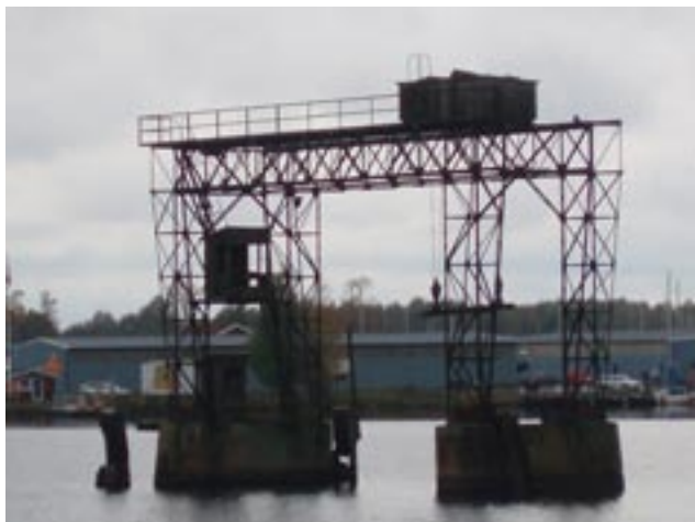
Buntkranen i Yttre hamnen var ett av förslagen till tävlingen "Vad vill du K-märka?". Den byggdes förmodligen på 1920-talet och användes för att bunta timmer. Dessa bands sedan ihop till långa timmermosor som flottades över Väneren till Vargön. Kranen var i drift fram till 1965 då lastbilar tog över transporten. Foto: Dennis Kingsvik.
