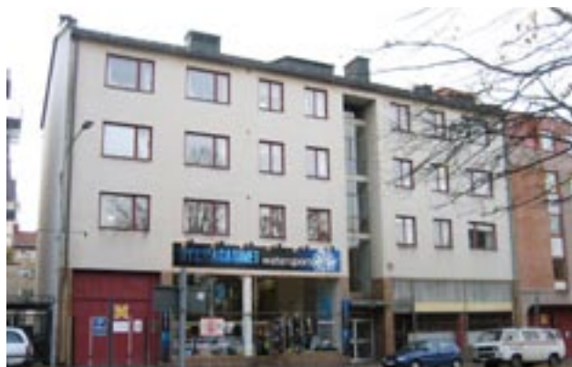
Funkishuset vid Norra Strandgatan 7 är ett av de hus som beskrivs i den första utgåvan av föreningens skriftserie "Karlstad med kulturhistoriska ögon". Foto: Föreningen Karlstad Lever 2008.
