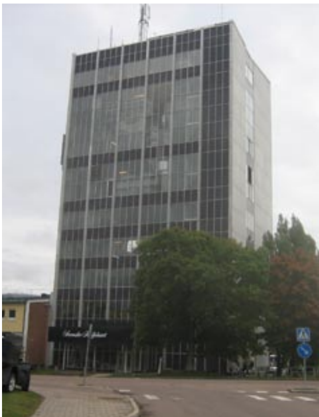
Den 42 meter höga kaffeskrapan uppförd 1960 efter ritningar av Wästlunds Arkitektbyrå.
