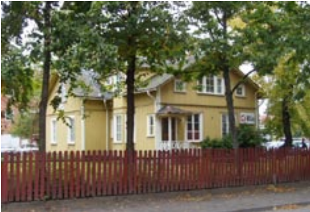
Högströmska villan i kvarteret Älgen föreslogs för K-märkning. Huset flyttades hit från Magskog 1872 av dåvarande stadsarkitekten Theodor Höström. Det övertogs på 1920-talet av hans son Arvid som byggde om det för sin läkarpraktik som han drev fram till 1940-talet då han blev stadsläkare.
