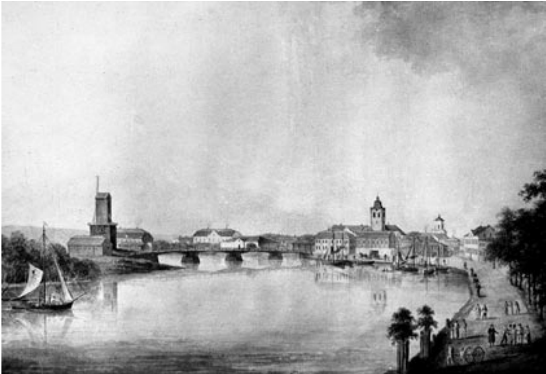
Akvarellmålning från omkring 1800 som visar Karlstads siluett från väster. Till vänster ses Hybelejens kvarn. Bakom bron skimtar den för staden ekonomiskt viktiga Järnvågen som uppfördes av Hybelejen 1789 - 95 (och som byggdes på med en andra våning 1862). Till höger ses Älvgatan och i fonden hamnen som fungerade fram till mitten av 1800-talet. Foto: Värmlands Museum.
